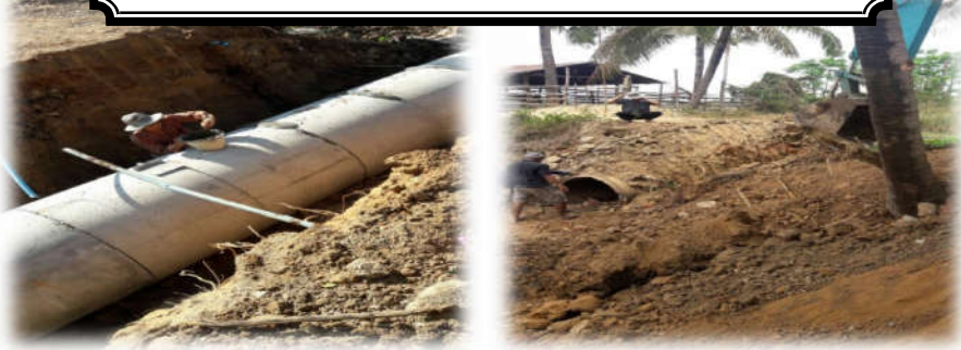
โครงการวางท่อระบายน้ำ คสล. สายคันคลองชลประทาน ม.๕
