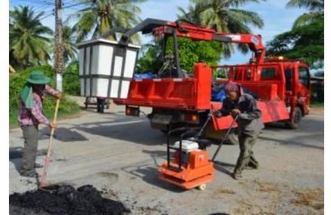
ปรับปรุง/ซ่อมแซมถนน
