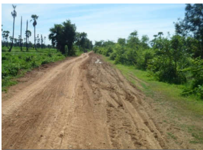
ซ่อมแซมถนนสายไรโคก-ดอนซ้อฟ้า
