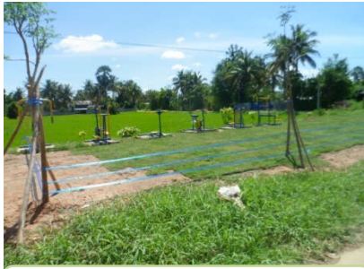
ปรับปรุงภูมิทัศน์สาธารณะ ม.4
